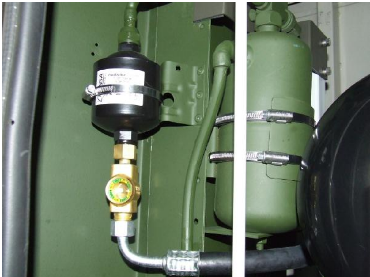
Rys 3b Widok skraplacza – osuszacz wziernik i butla
