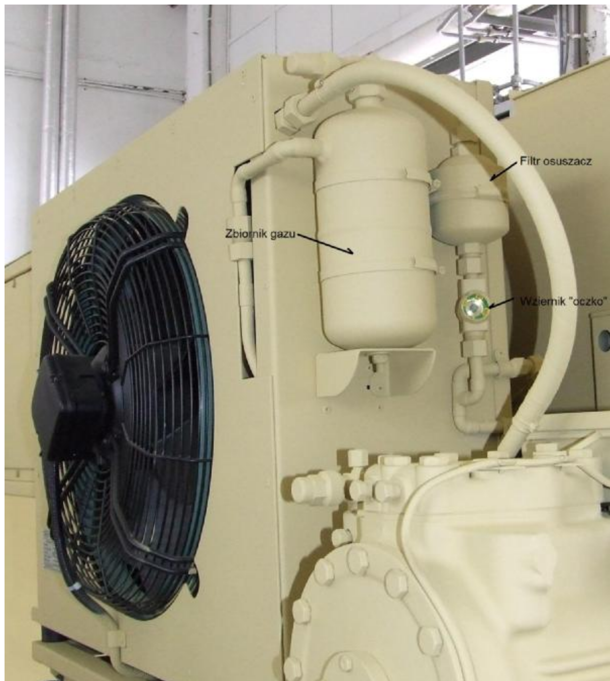
Rys 5 Widok skraplacza – osuszacz wziernik i butla
